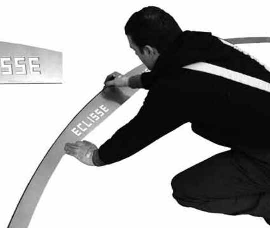
10c) Contrassegnare a quota "0" seguendo il bordo della dima
